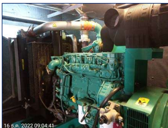
รูปที่ 2.28 เครื่องกำเนิดไฟฟ้า
