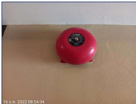
รูปที่ 2.44 สัญญาณแจ้งเตือนเหตุเพลิงไหม้
